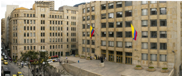
Ilustración 3. Edificio Murillo Toro - Sede MinTIC
